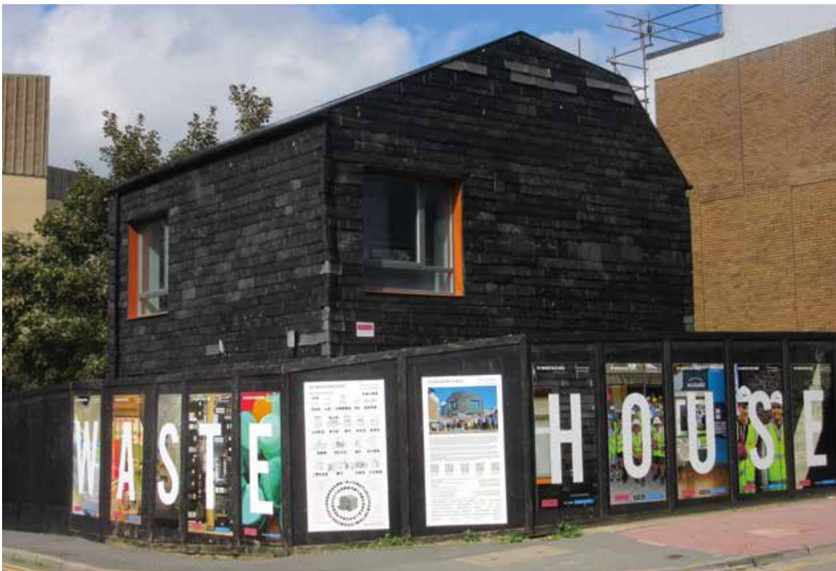
Das Waste House in Brighton besteht fast nur aus weggeworfenen oder kaputten Gegenständen. Die Materialien bestehen z. B. aus Bau- und Hausmüll wie Zahnbürsten, alten Jeans, Videokassetten und Fahrradschläuchen.
