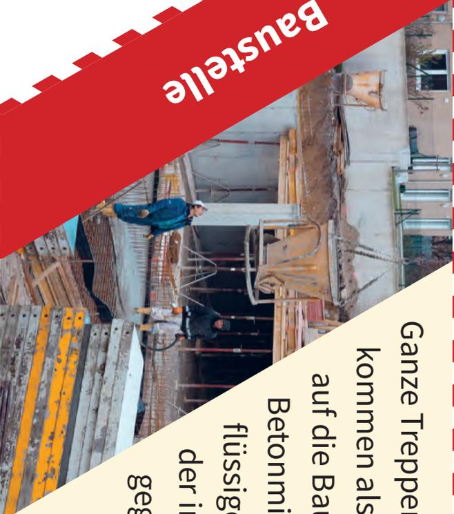
Ganze Treppen, Wände oder Decken kommen als ganze Bauteile auf die Baustelle, oder Betonmischer liefern flüssigen Beton, der in Formen gegossen wird.
