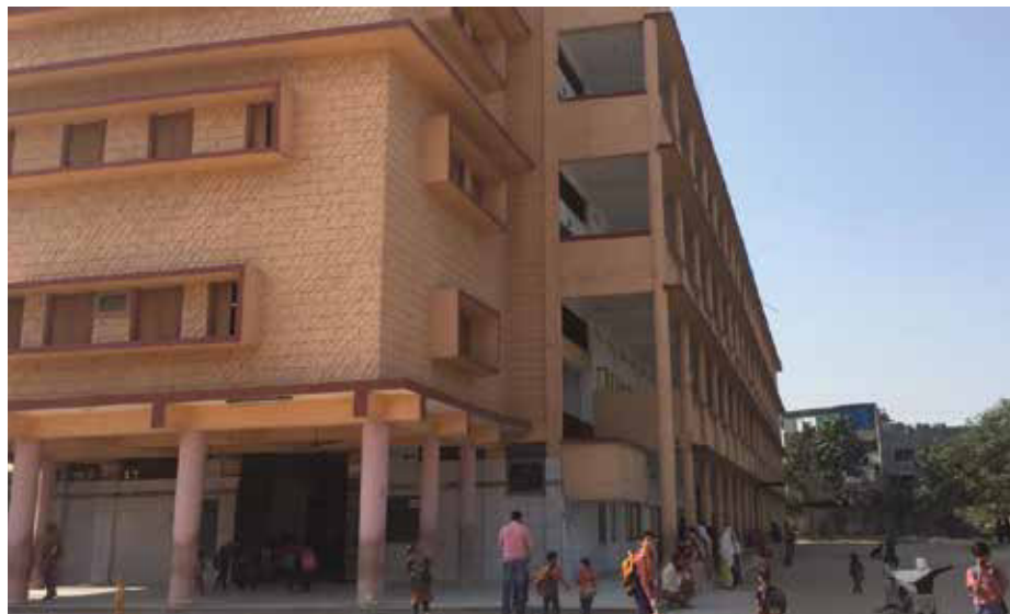
Schulgebäude der F. D. Primary school Ahmadabad, Indien
