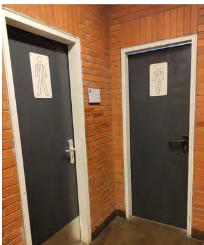
Zwei Toilettenräume wurden renoviert
